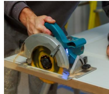
Détalonnage des portes
