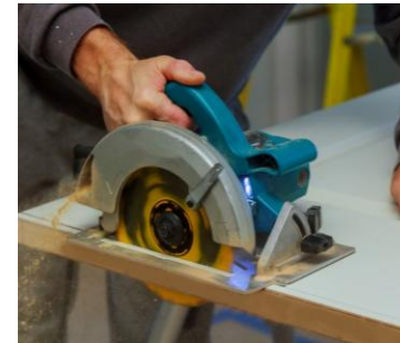
Détalonnage des portes
