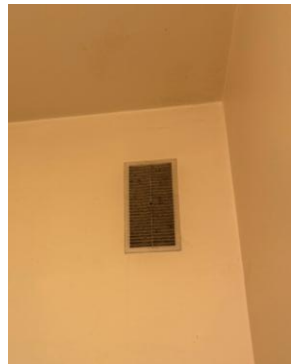
Bouche d'extraction située dans les salles humides
